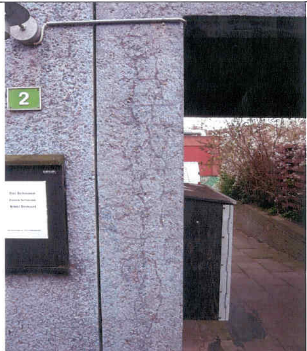
Eksempel på netrevner i blå søjler.
