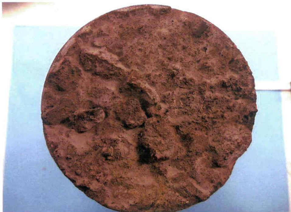
Kerne K1: Overfladen på yderside (udboringssiden) med frilagt stentilslag.
