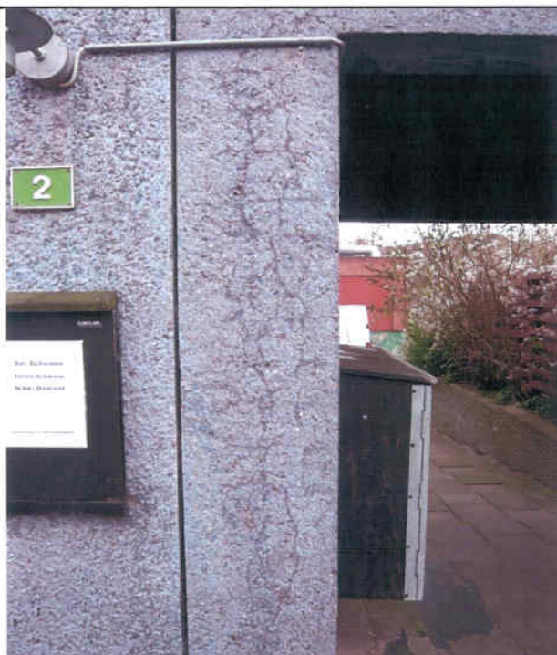
Eksempel på netrevner i blå søjler.
