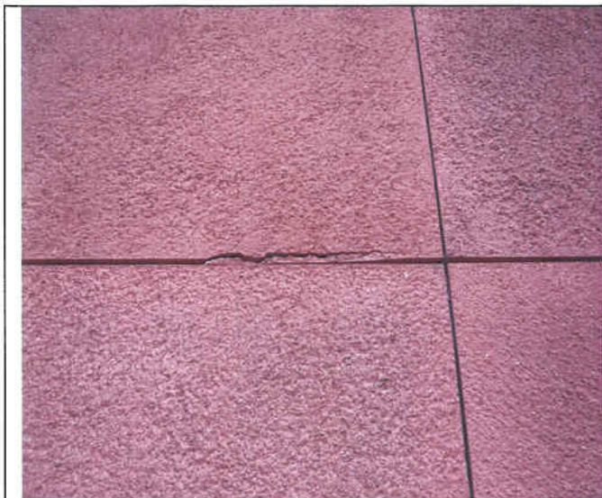
Afskalning af nederste del af element ved Torvelængerne 1.
