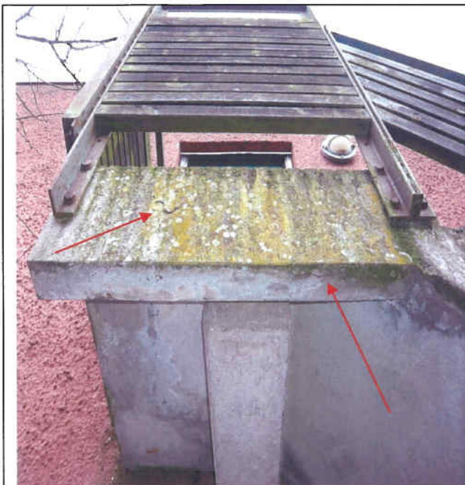
Eksempler på skader på trapper, her på trappevange.
