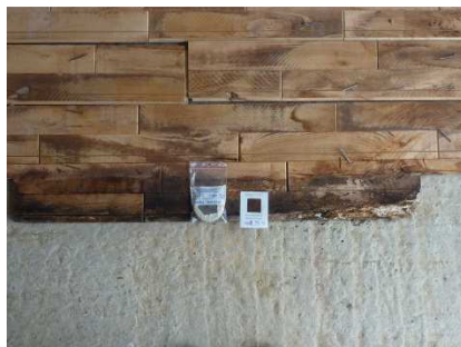
Bagside af gulv ved hoveddør
