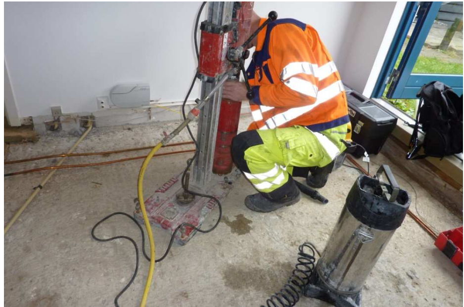
Udtagning af borekerne i terrændæk i stue efter gulvkonstruktion er fjernet.
