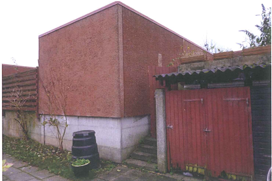
Foto af gavl med høj sokkel. Gulv overside er placeret cirka 20 cm over underkant af facadeelement.
