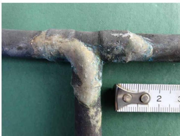
Figur 6 Udflydende loddemateriale og flusmiddel omkring T-stykke.
