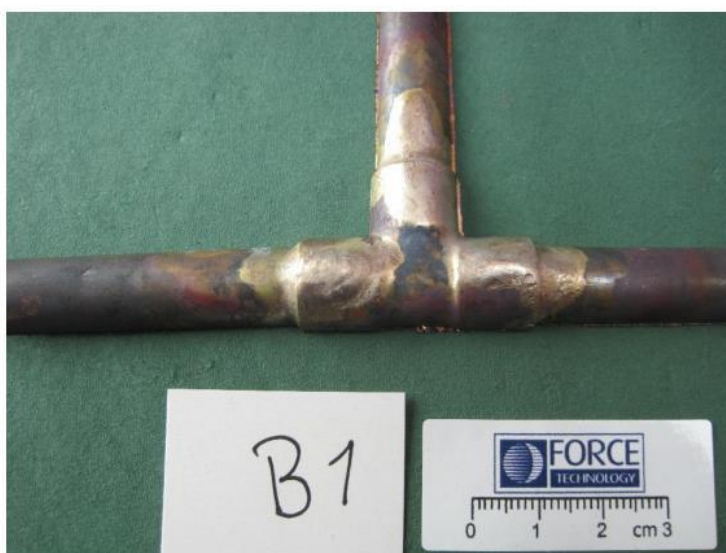
Figur 9 Udvendig overflade på Rørprøve B1 efter afrensning.
