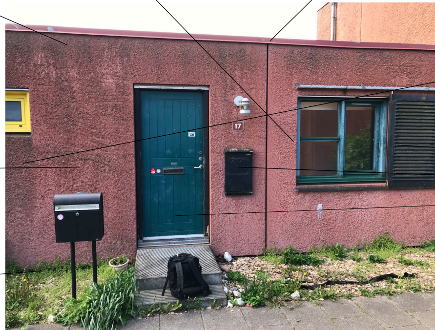
Udskiftning vinduer; hvid indvendig, udvendig samme farve som eksisterende
