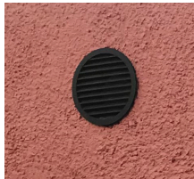
Facadeintegreret ventilation Betonreparationer (evt. på anden adresse)
