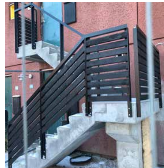
Prøve på to- forløbs trapper og støbning af ny beton plint.
