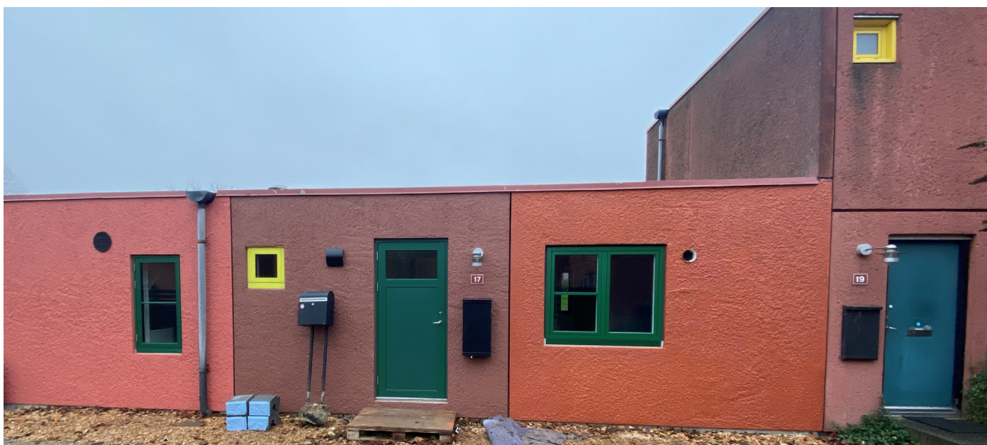
Tømmerstræde 17, har været prøvebolig for bl.a. nye vinduer, tag, sternkant mv. samt med prøve på facadefarve. Den endelige facadefarve bestemmes når renoveringen begynder.
