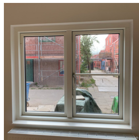
Når du drejer håndtaget op i lodret position, åbner vinduet til kip.
